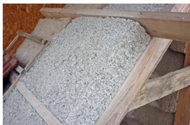
Paroi de béton de chanvre dans une ossature bois.
