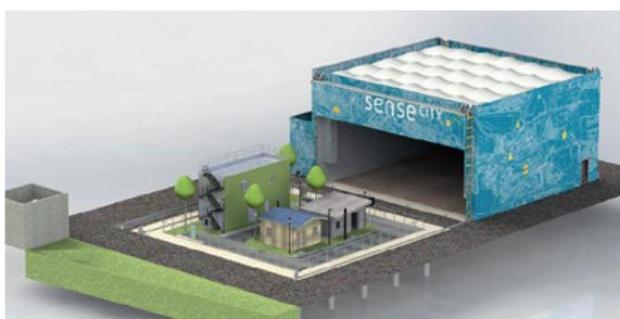
Mobile, la halle climatique permet d'effectuer des mesures *in situ* en conditions réelles ou instrumentées.
